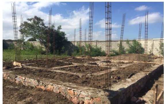
Das Fundament des neuen Waschblocks ist gelegt
