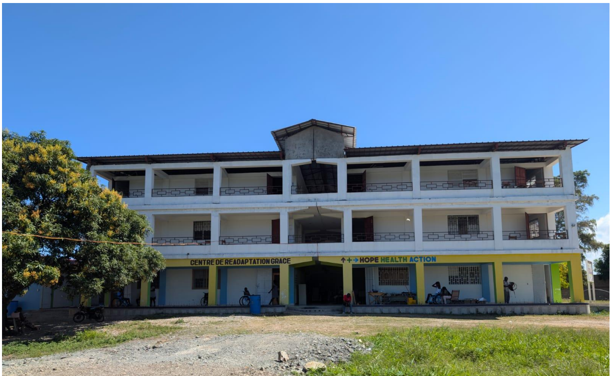
Das neue Rehabilitationsgebäude in Cap-Haitien
